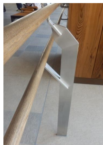
自由通路 手すり
