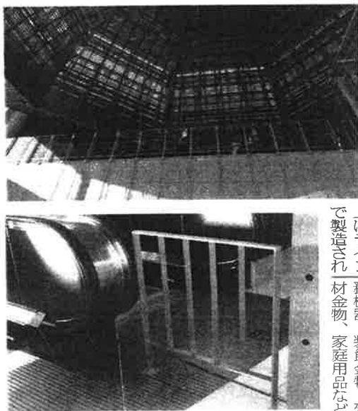
東口ホール手すり、エスカレーター付近の安全柵
